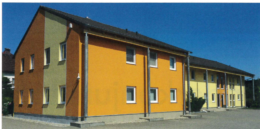
Ein Sockel ist die Basis des Gesamtprojekts und ein gutes Fundament für die Dämmung.
